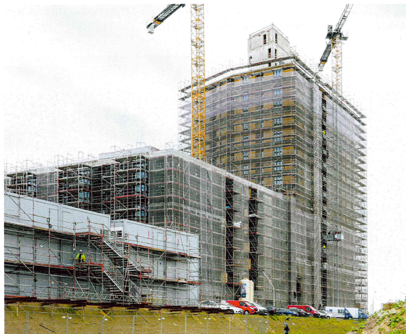
Nach zweijähriger Bauzeit war das Holzhochhaus Roots in der Hamburger Hafencity Anfang 2024 bezugsfertig.
