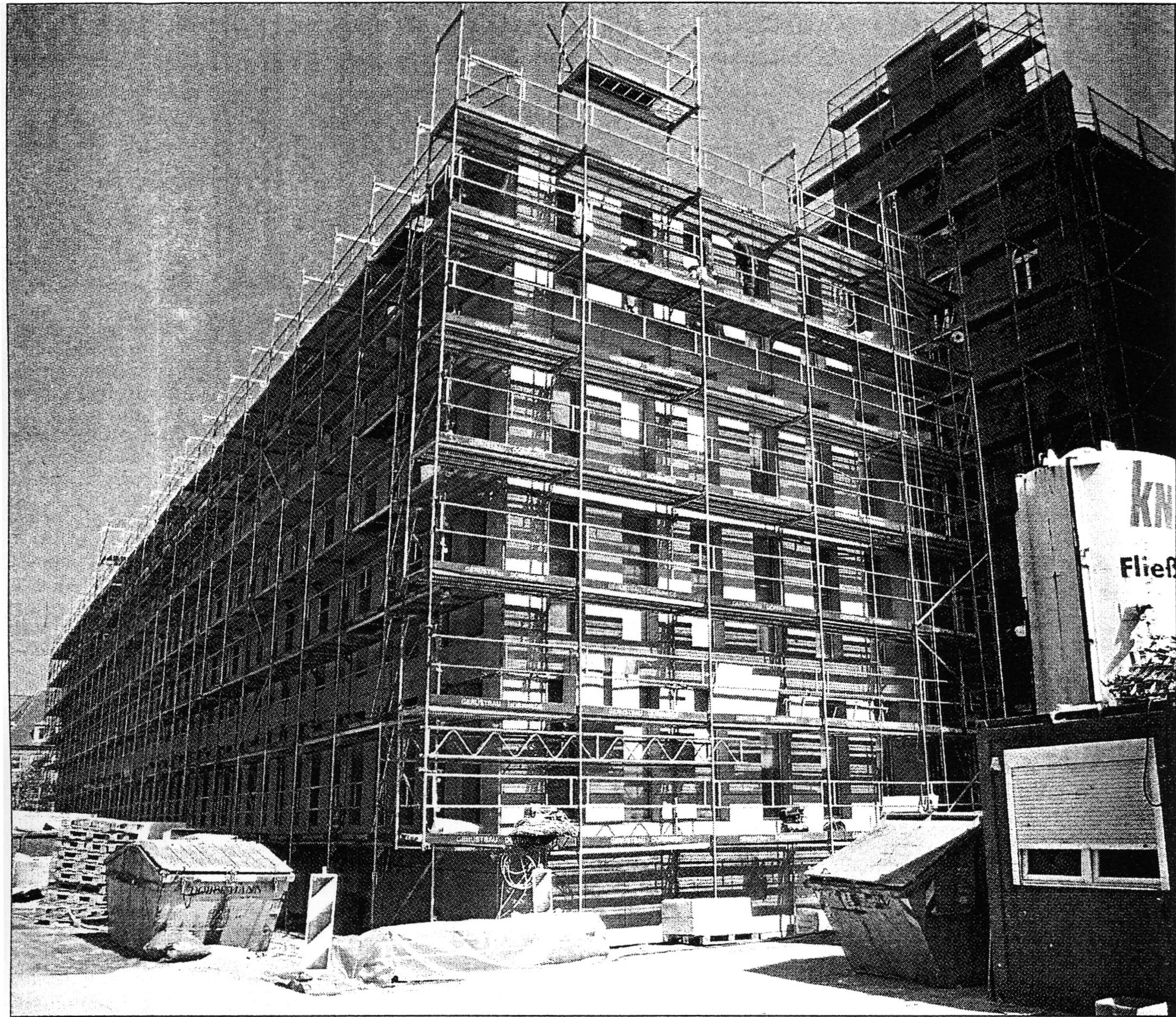
Imposant erhebt sich die neue Diözesanbibliothek im Herzen Münsters mit ihrer neoromanischen Fassade – auf diesem Bild noch während der Bauarbeiten. Fotos: Bistumsarchiv
